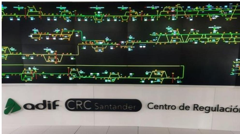
El control de las estaciones se realiza a través de cable y fibra óptica, por canalizaciones subterráneas, lo que aumenta la fiabilidad de las instalaciones que, anteriormente, se veían afectadas por diferentes incidencias, como tormentas, actos vandálicos, etc.
